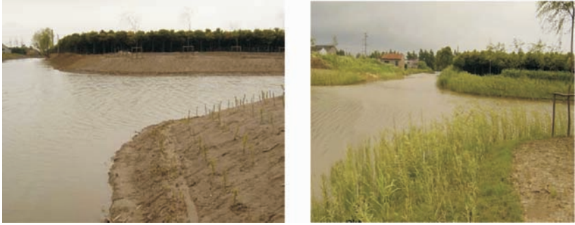
图2 镇畅塘港 - 沙脚河交界处坡岸的活枝扦插
