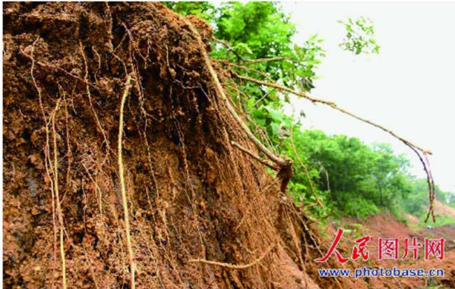
图 10-19 在巢湖南岸堤坝上被风浪冲出的裸露的树根
